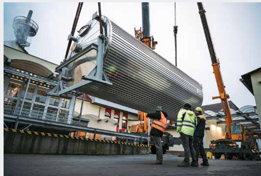
Instalace centrální nádrže na teplou vodu
