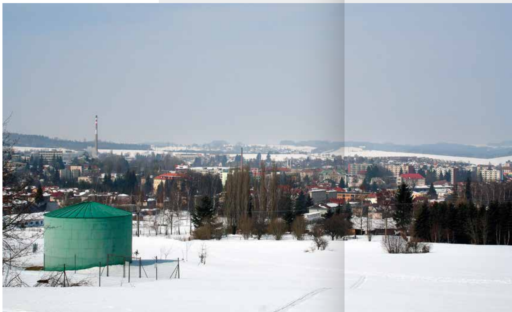
Vodojem nad Humpolcem
