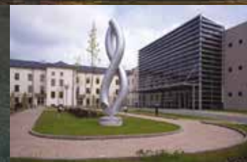
REKONSTRUKCE ŽIŽKOVÝCH KASÁREN NA SÍDLO KRAJE VYSOČINA, JIHLAVA
