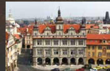
REKONSTRUKCE MALOSTRANSKÉ BESEDY, PRAHA 1
