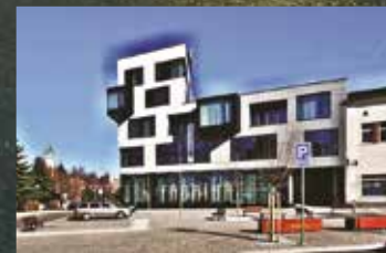
NOVOSTAVBA - FABRIKA HOTEL, HUMPOLEC
