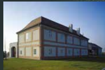
REKONSTRUKCE USEDLOSTI LADRONKA, PRAHA 6
