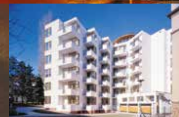
NOVOSTAVBA DOMU S PEČOVATELSKOU SLUŽBOU, PRAHA 6
