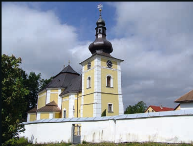
kostel v Obyčtově
