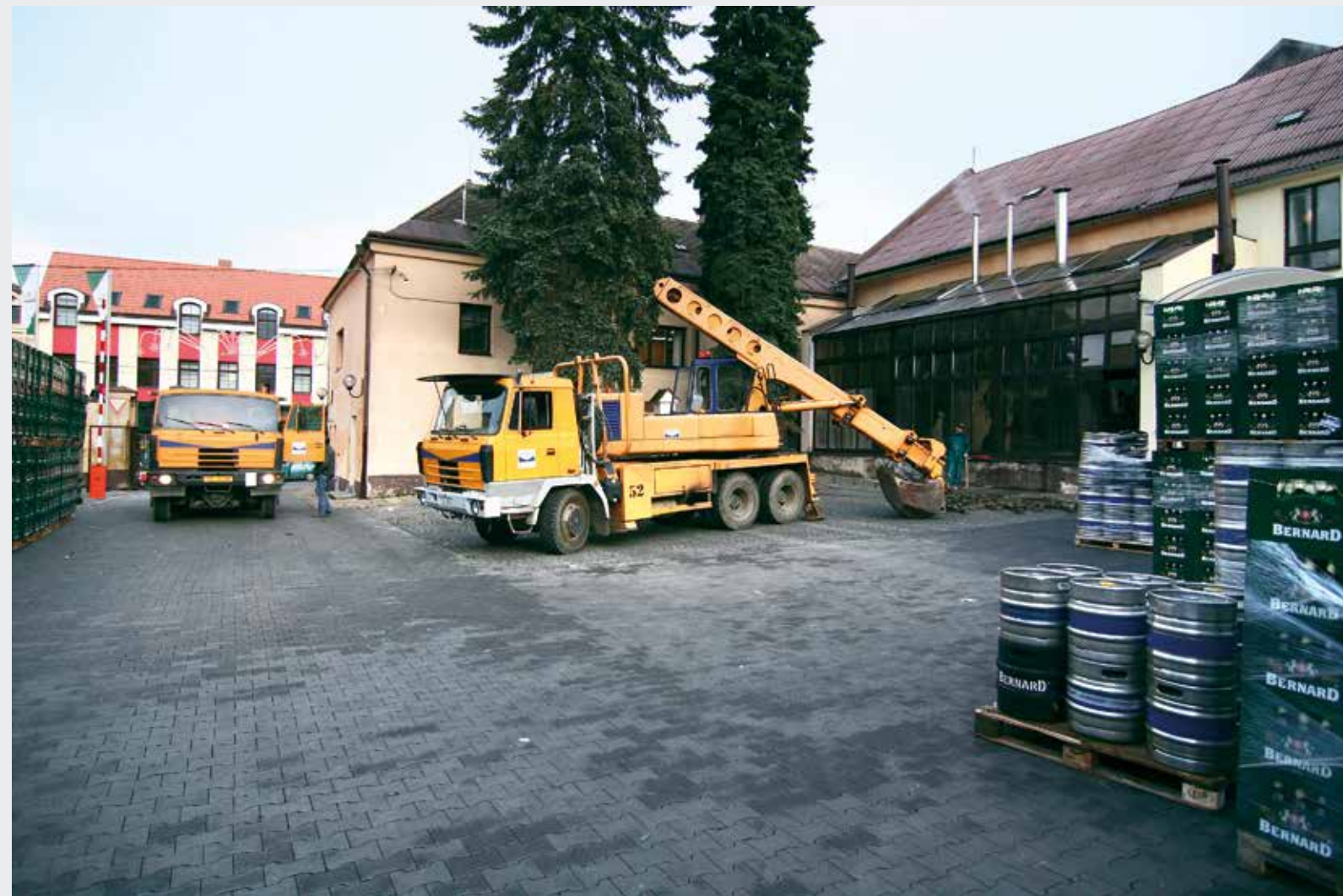
Potřebné bylo i předláždění pivovarského dvora
