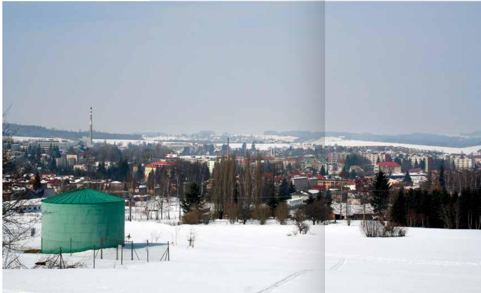
Vodojem nad Humpolcem
